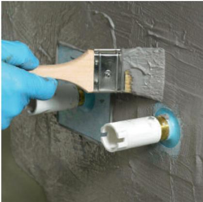
Die Dichtmanschetten PCI Pecitape 10 x 10 ordnungsgemäß einbetten.
