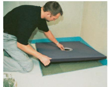
Mit dem Unterbauelement PCI Pecibord® können barrierefreie Duschbereiche in vielen verschiedenen Geometrien und Größen schnell und sicher hergestellt werden.
