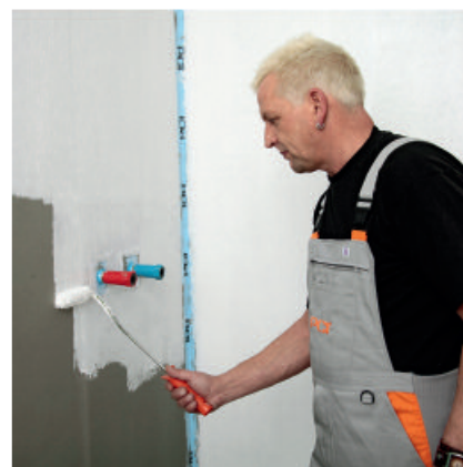
PCI Lastogum wird unverdünnt durch Rollen, Streichen oder Spachteln auf den Untergrund aufgebracht.
